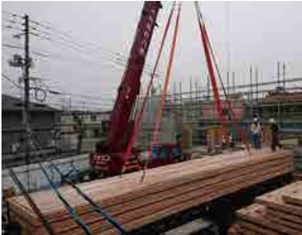
2階・3階の床には国内最大サイズとなる3m×12mのCLTパネルが使用されている
