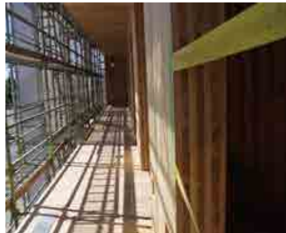
南側の壁には210mm厚のCLTを使用している
