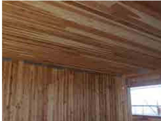
2階・3階の床には国内最大サイズとなる3m×12mのCLTパネルが使用されている
