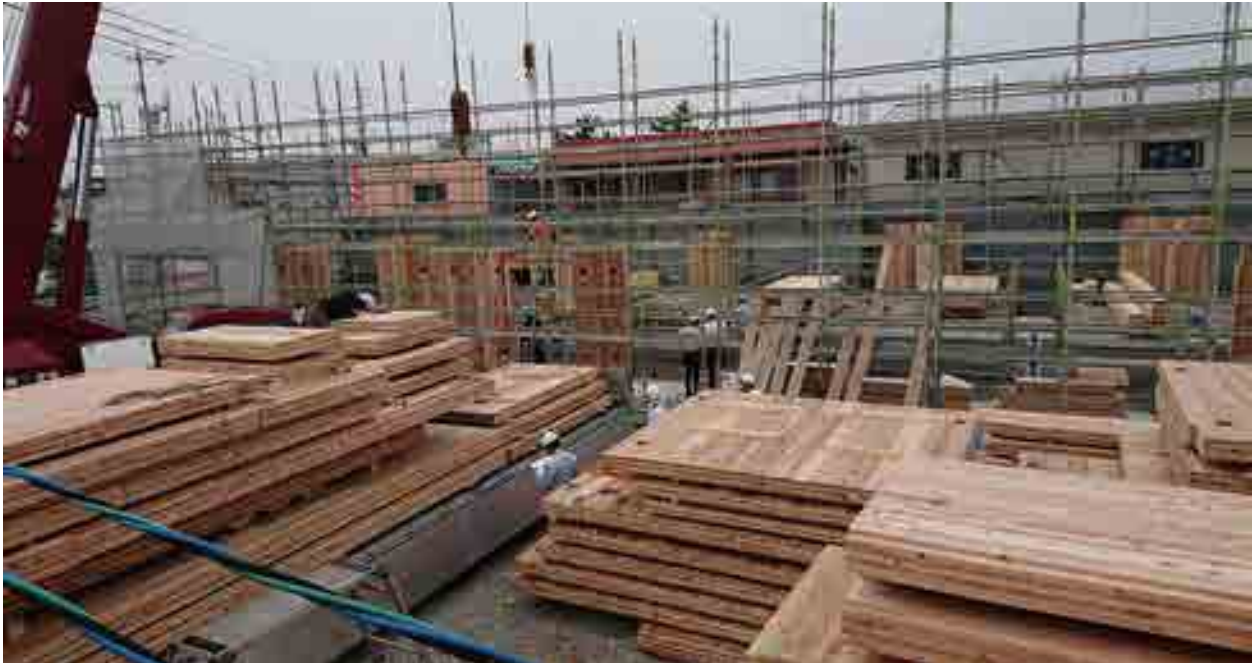
建て方に要した日数は約8日間で、総作業員数は160人工となっている
