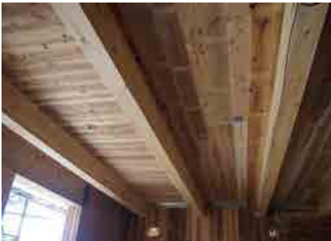
CLTパネルと小梁を一体化した「リブ付きCLTパネル」
